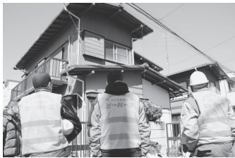
訓練で使用する解体家屋
